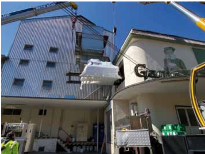
Spektakuläre Einbringung des neuen Flaschenfüllers bei Gampertbräu in sechs Metern Höhe
